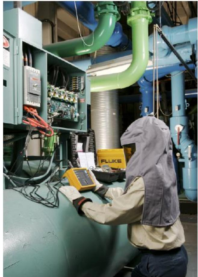
但是Klingler有信心找到平衡点，他可以在改造前利用Fluke 975空气质量测试仪工具测量多项IAQ因数，然后检查空气质量是否受到影响。并且他不必估计或猜测能耗情况，而是利用beta测试版的Fluke 1735电能记录仪记录冷冻机在数个12小时周期内的耗电度数。
